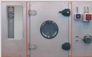
Za bezstupanjsko reguliranje broja okretaja (5 do 90 Hz) motora ventilatora s kvadratnom krivuljom zakretnog momenta, otklanjanje radijskih smetnji u skladu s EN 55011 i EN 61800-3 putem filtra za suzbijanje radijskih smetnji. Spojna veza između motora i pretvarača oklopljenim kabelom. Ugrađena zaštita motora nadzorom hladnog vodiča. Ožičen u kombinaciji s rasklopnim ormarom i unaprijed parametriziran na mjestu ugradnje.
